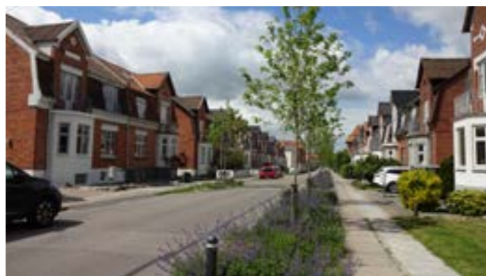
Vejbede på Hordumsgade
