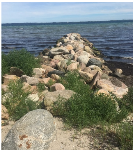
Eksempler på de to hyppigst registrerede kystsikringsanlæg: stensikring og høfder.
