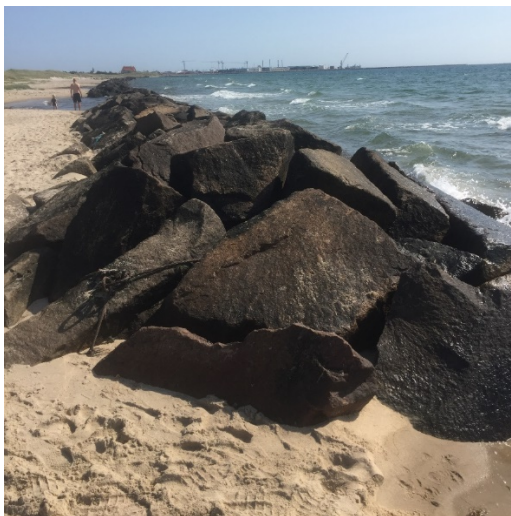
Eksempler på de to hyppigst registrerede kystsikringsanlæg: stensikring og høfder.
